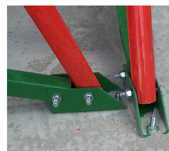
ancrage sur dalle du sabot de béquille
